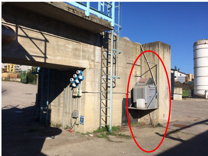
Figura 3: Campionatore automatico portate in ingresso al trattamento biologico.
