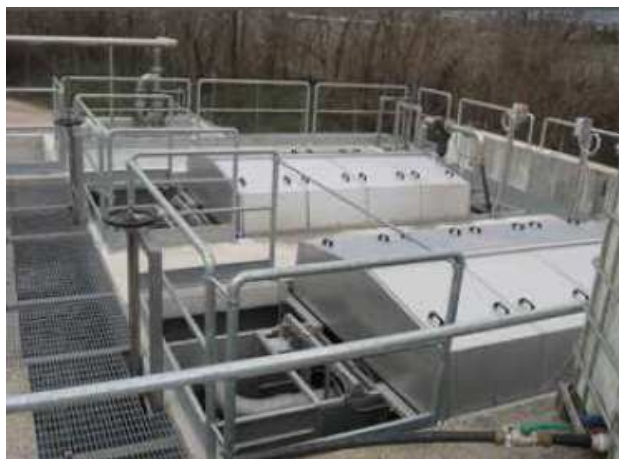
Figura 9: Sistema di filtrazione a dischi.
