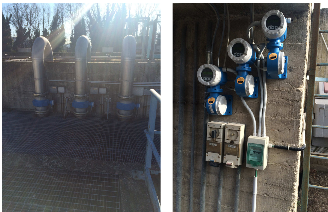
Figura 6: Ubicazione misuratore di portata in ingresso
