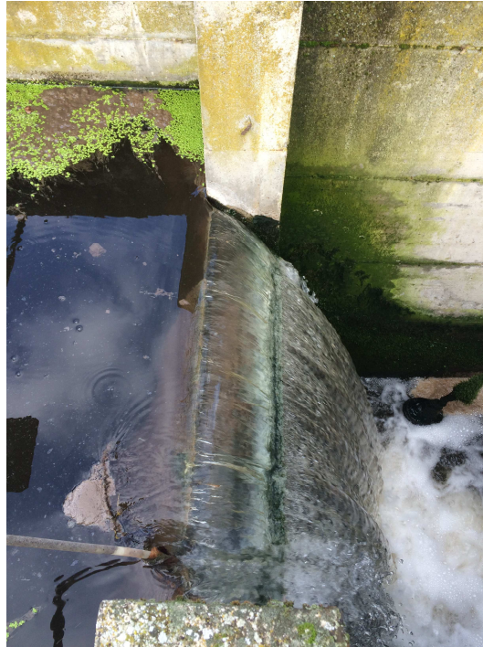
Figura 7: Stramazzo nel canale di clorazione in uscita dall'impianto
