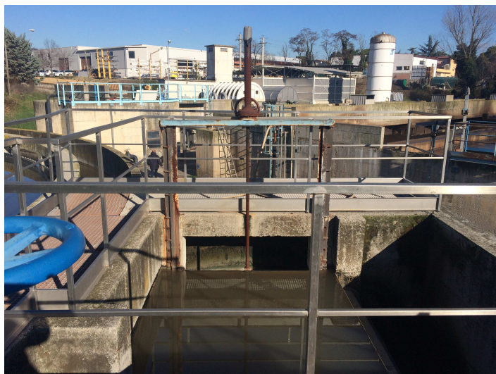
Figura 11: Paratoia in ingresso alla sezione biologica dell'impianto ubicata a valle dei pretrattamenti.
